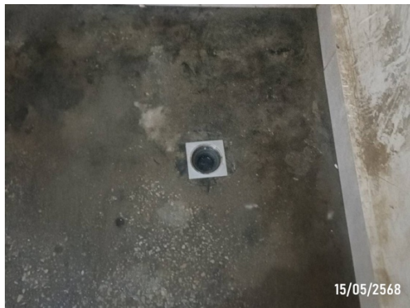
รูปที่ 2-20 ท่อรวบรวมน้ำจากการล้างห้องพัสดุ ฝอยรวม
